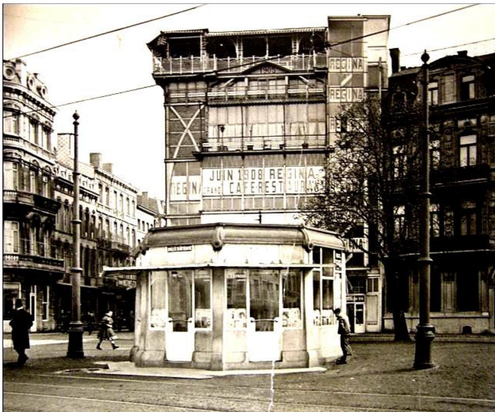
Le Régina en construction en 1908
